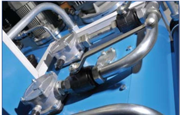
Montirana cev - instalacija na hidrauličnom agregatu
